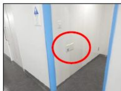
兵庫県洲本市 トイレ音声案内設備
