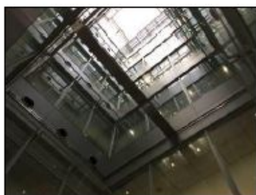
紀の川市 自然光と風を利用した 吹き抜け空間システム (エコボイド)
