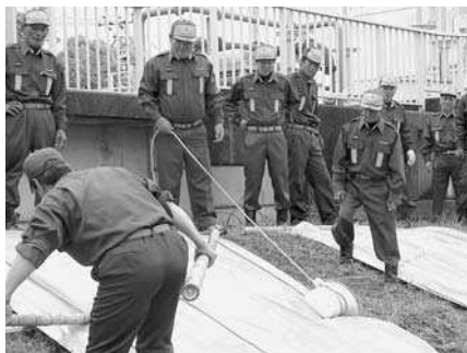
シート張り工法
