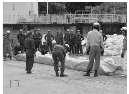
改良積み土のう工法
