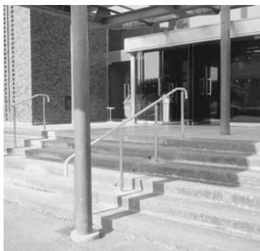
市民会館玄関手摺り
