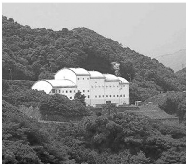
ドリームフューエルセンター 可燃ごみ処理施設(固形燃料化施設)
