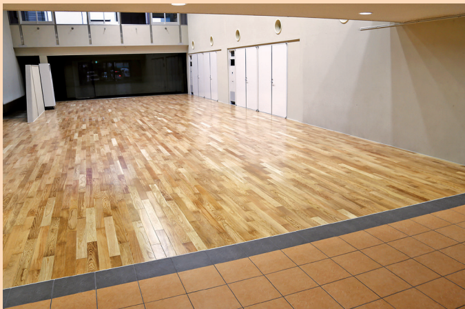
展示ホールは、玄関ホールと同じ高さまで床をかさ上げし、バリアフリーとしました。また、照明も明るくしたことで、イメージがガラリと変わりました。
