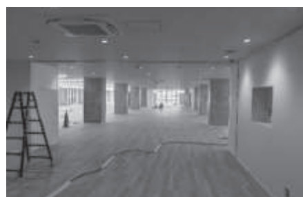
2階待合ホールの様子
