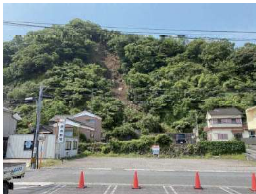
宮山北側法面の土砂崩れ（2021）
