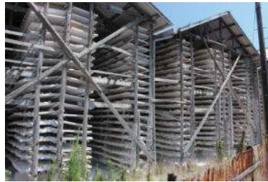
石灰乾燥棚 (白石工業株式会社津久見工場)
