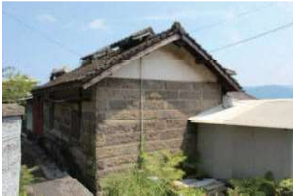
長目伊崎地区に残る 灰石積みのみかん小屋
