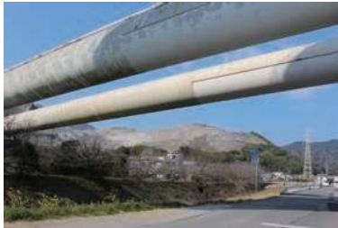
町を横切るパイプ (ベルトコンベア) (岡町)
