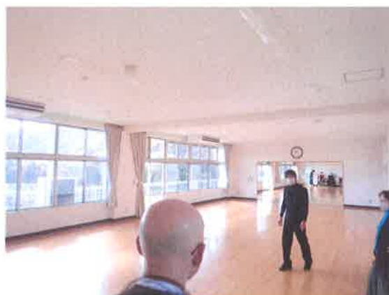
多目的ホール（壁を撤去）
