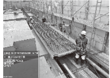
庇(ひさし)の取付け(6月)
