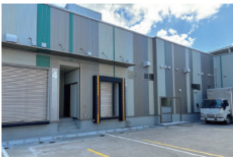
新しく完成した別棟で食器の洗浄とアレルギー対応食の調理を行います
