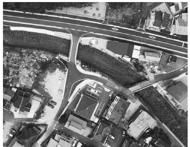
千怒越橋上空写真
