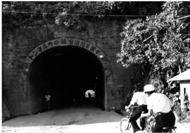
拡幅工事前の下浦トンネル
