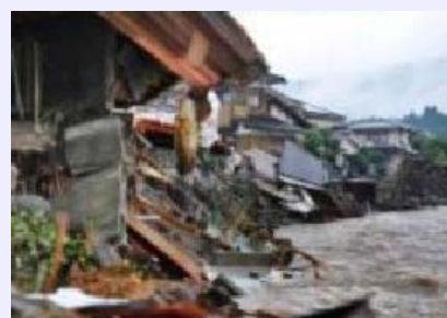
河岸侵食に伴う家屋倒壊等
