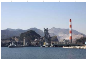
石灰石鉱山と工場群 (堅徳地域)
