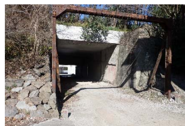
ＪＲ線路の横断箇所
