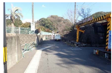
福地区ポンプ設置箇所
