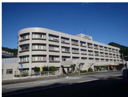
避難ビルの津久見中央病院
