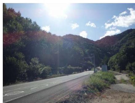
千怒越トンネルに続く避難路
