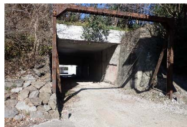
ＪＲ線路の横断箇所
