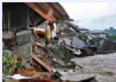
河岸侵食に伴う家屋倒壊等
