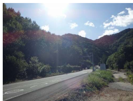
千怒越トンネルに続く避難路
