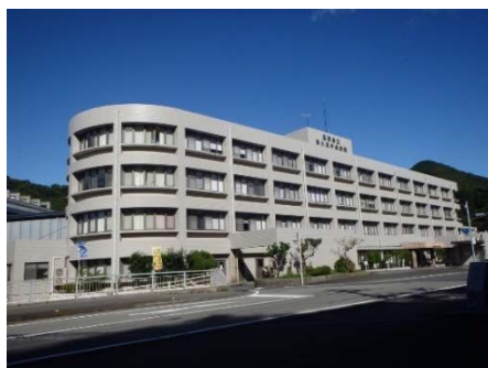
避難ビルの津久見中央病院
