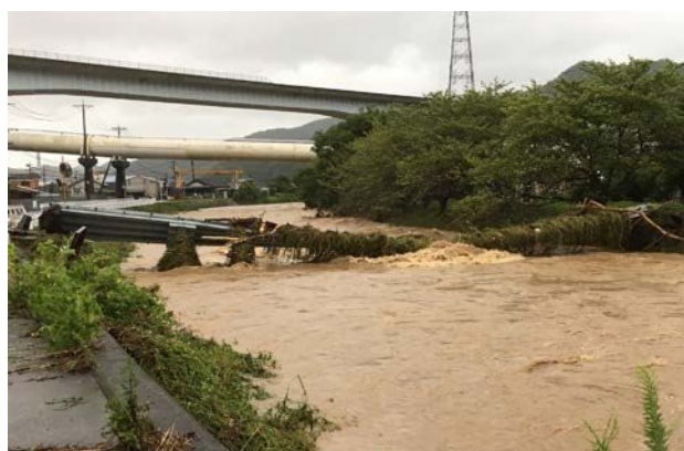
台風第18号により青江川道籠橋が被災した様子
