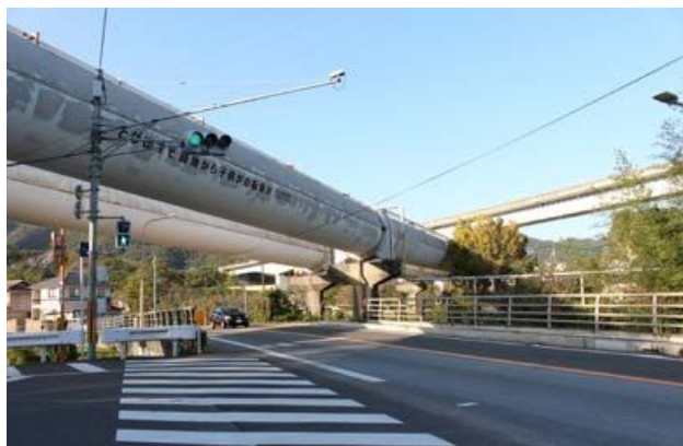
一般道路と交差するパイプライン
