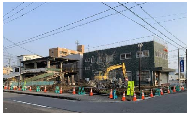
角崎公園（工事中）
