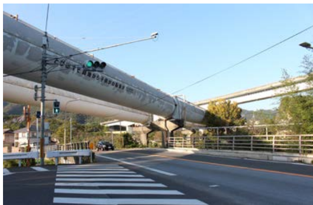
一般道路と交差するパイプライン
