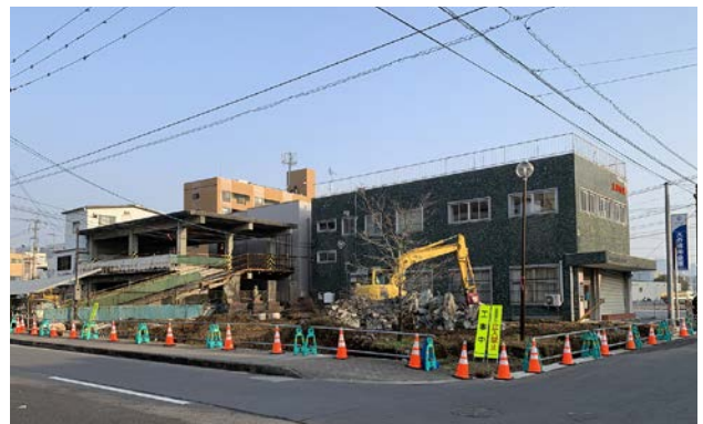
角崎公園（工事中）
