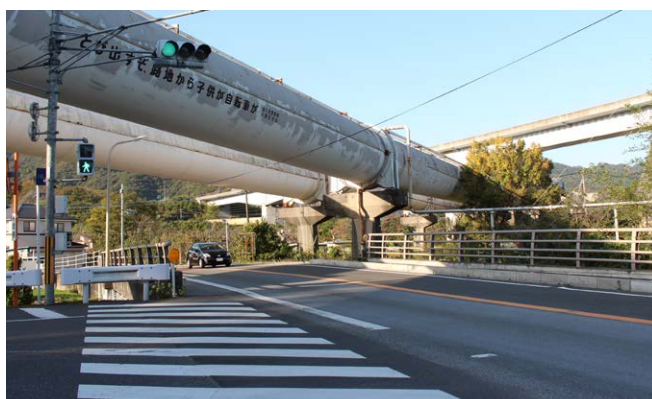
一般道路と交差するパイプライン
