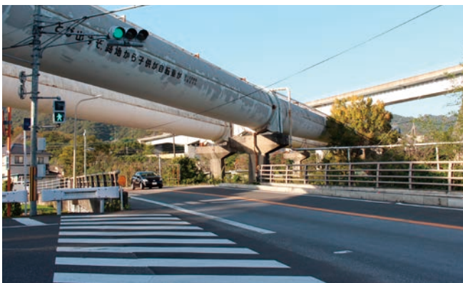
一般道路と交差するパイプライン
