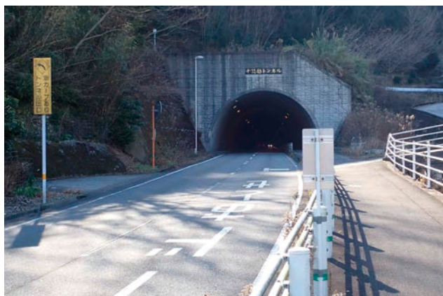
災害時の避難路となる千怒越トンネル（千怒地域）
