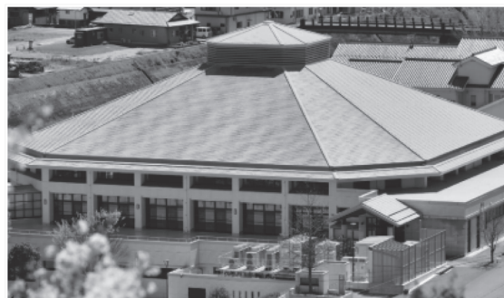
復旧した乙亥会館
