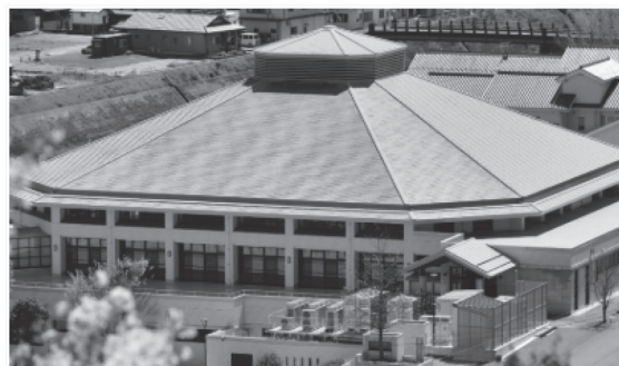
復旧した乙亥会館
