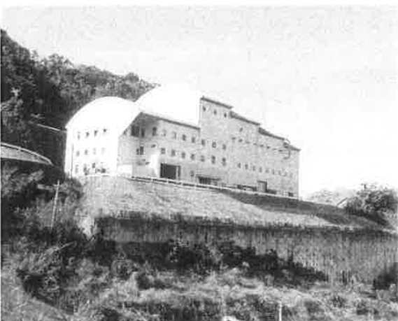
ドリームフューエルセンター
