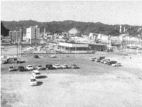
大型スーパーの完成へ着々進む工事
