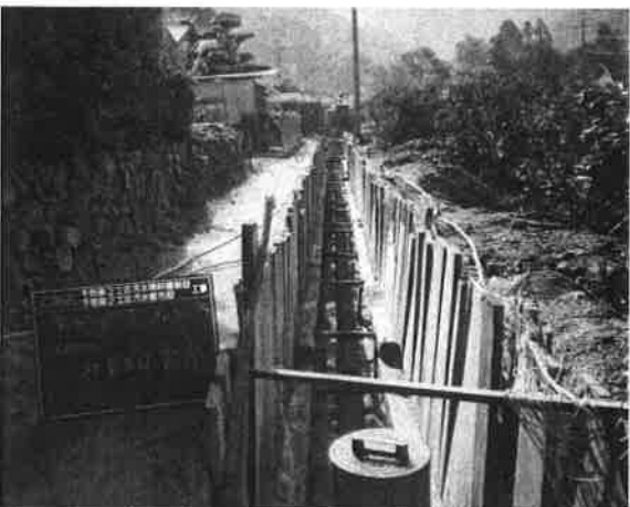
下水道つなぎ込み
